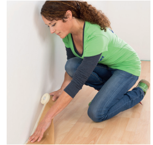
Decke und Boden abkleben
