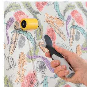
Angrenzende Bahn andrücken
