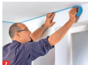
2 Angrenzende Flächen, die nicht tapeziert werden, mit Kreppband abkleben.
