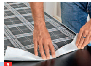
9 Weitere benötigte Bahnen ausrollen und ablängen.
