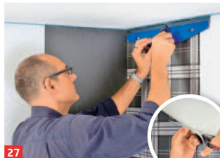
27 Große Überstände grob mit der Schere abschneiden, exakte Schnitte mit Spachtel und Cutter vornehmen.
