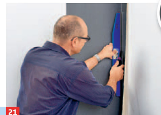
21 Bahn mit dem Tapezierspachtel in die Ecke drücken und Überstände entlang des Spachtels anschneiden.
