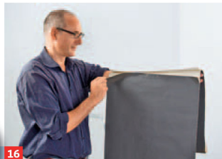
16 ... weichen lassen (5 bis 10 Minuten, je nach Materialstärke). Zum Anbringen die Bahn mit dem oberen Ende zum Körper ...
