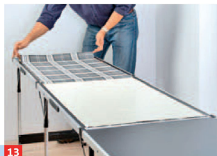
13 ... bzw. Kleister direkt abwischen. Jetzt das untere Ende der Bahn zu 1/3, ...
