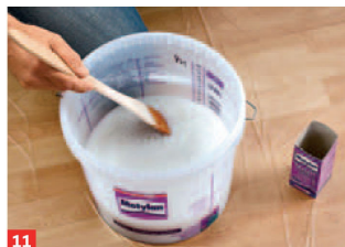
11 Den angesetzten Kleister nun nochmals aufrühren. Übrigens: Für eine optimale Mischung stets komplette Pakete anrühren.
